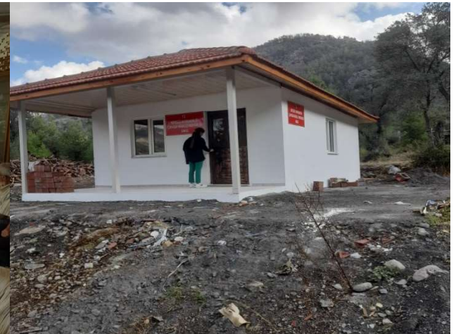
Çayhisar Mahallesi (Muhtarlık Binası)
