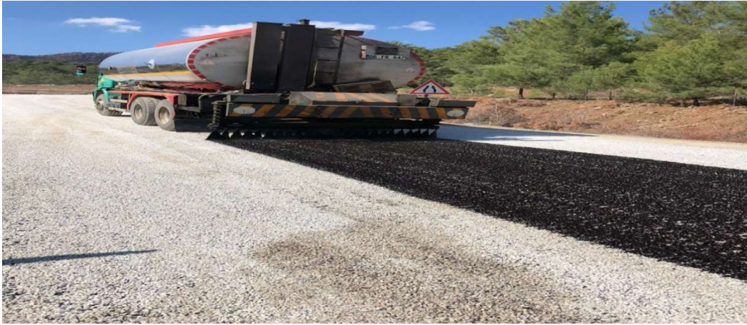
Görsel-21 Çövenli Mevkiine Bir Tabaka Astarlı Bitümlü Sathi Kaplama Yapılması 6 km
