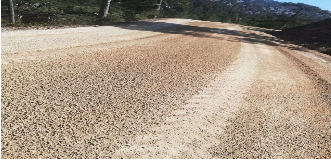
Görsel-20 Çövenli Mevkiine Bir Tabaka Astarlı Bitümlü Sathi Kaplama Yapılması 6 km
