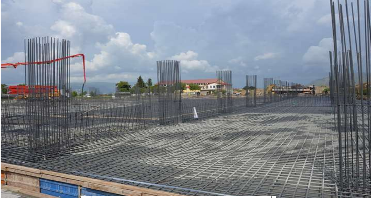
Görsel-3 Yeni Mahalle Kapalı Spor Salonu
