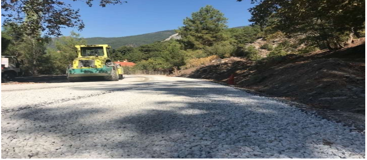
Görsel-22 Yayla-Beyağaç Yolu Asfalt Yapımı
