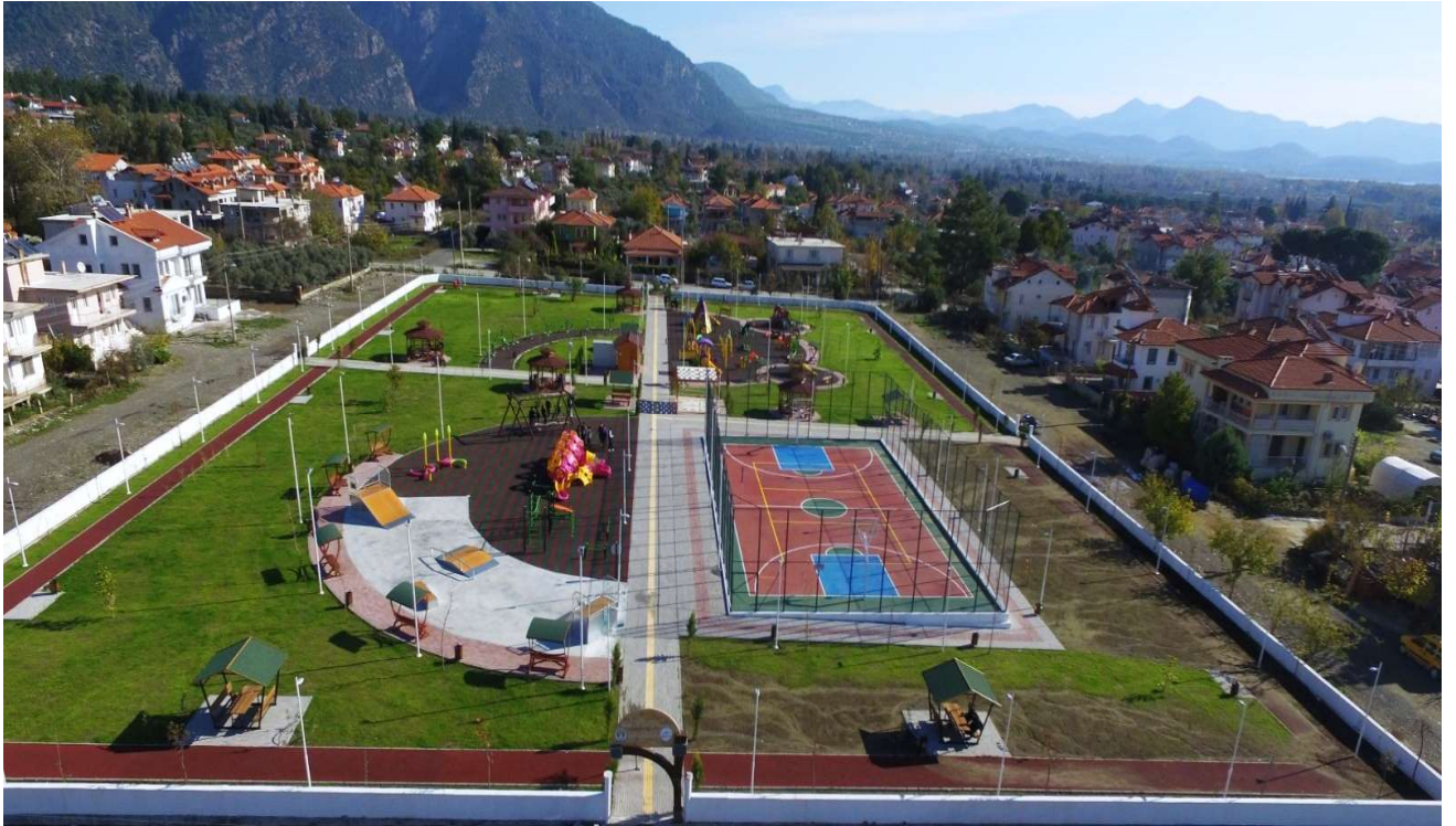
Görsel-17 Yeni Mahalle Park Yapımı
