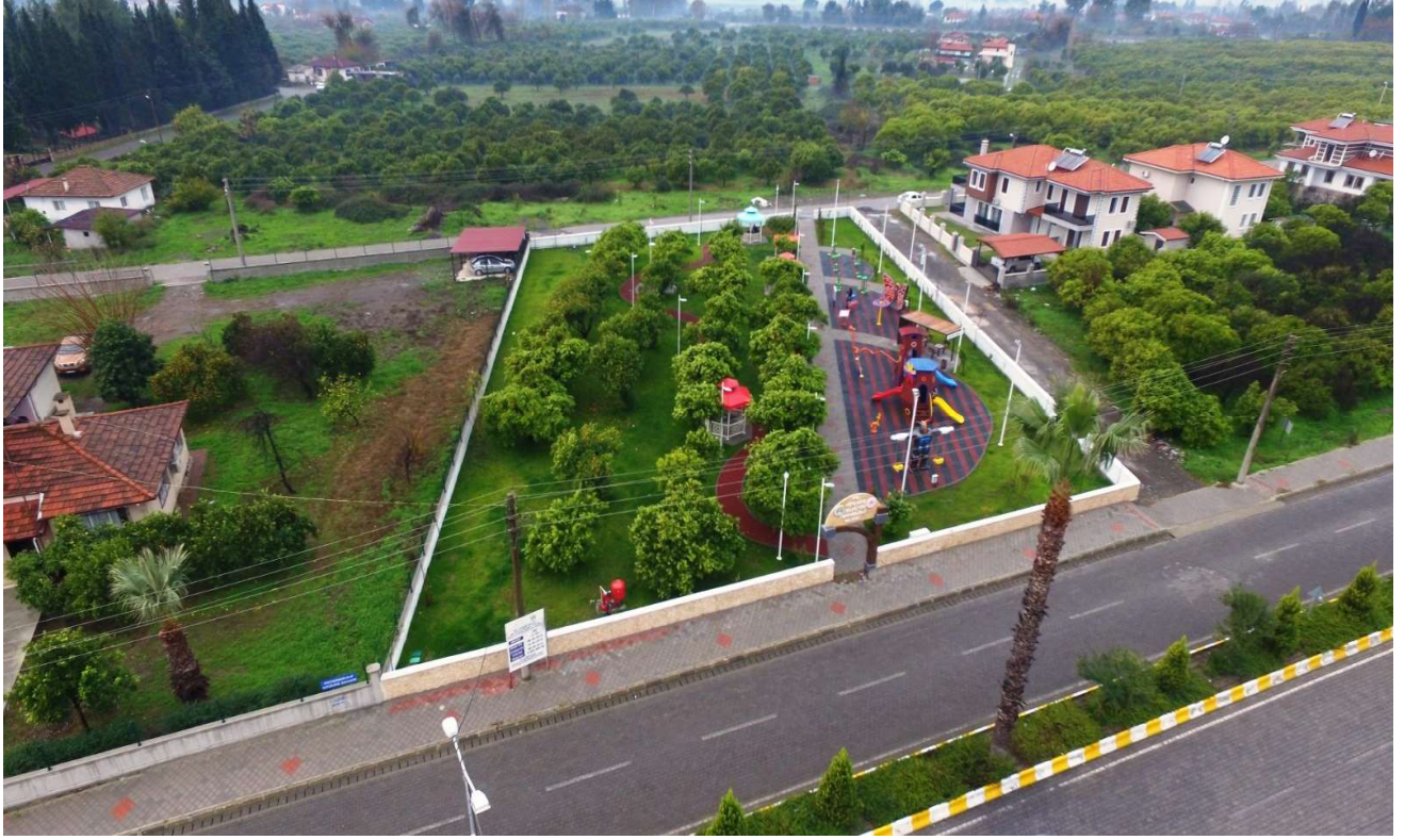
Görsel-18 Ulucami Mahallesi Park Yapımı
